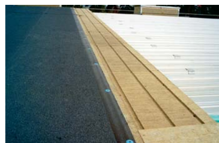
Рисунок 1: Сечение плоской кровли с применением пазовой теплоизоляции.
